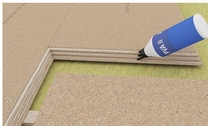
Figur 5 Før samling af pladerne påføres rigeligt lim på alle tre oversider af feren. Lim der presses op fjernes. Pladerne limes til alle strøer.
